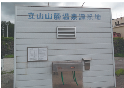
現在のポンプ室
