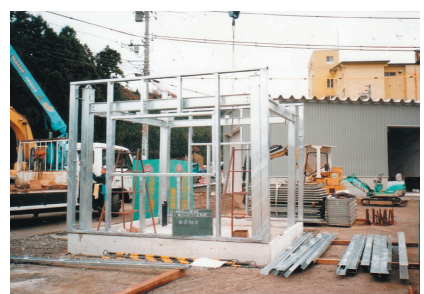
ポンプ室の組立作業
