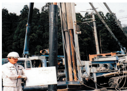
14" コンダクターパイプ ハンマー打
