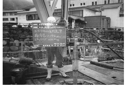
エアリフトにて孔内洗浄
