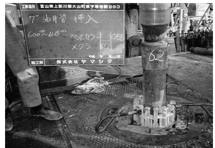
油井管 600m ケーシング 62 メクラ+ベルカラー
