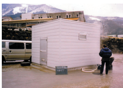
ポンプ室設置検査
