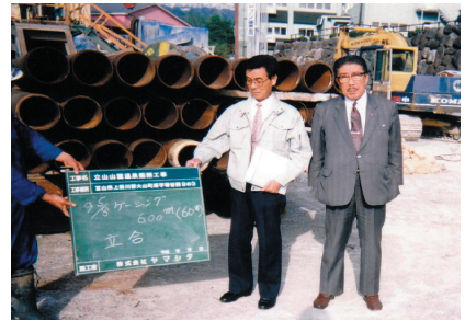
ケーシングの立会い
