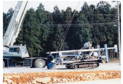
掘削機材の搬入
