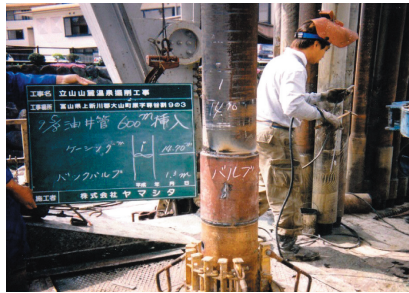
ケーシング作業の様子
