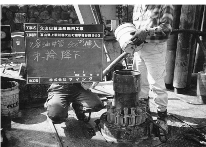
ケーシング 60 第一栓降下
