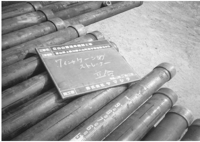
7" ケーシングパイプ・ストレーナー 立会
