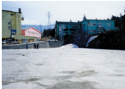
ホテル第一荘前の駐車場
