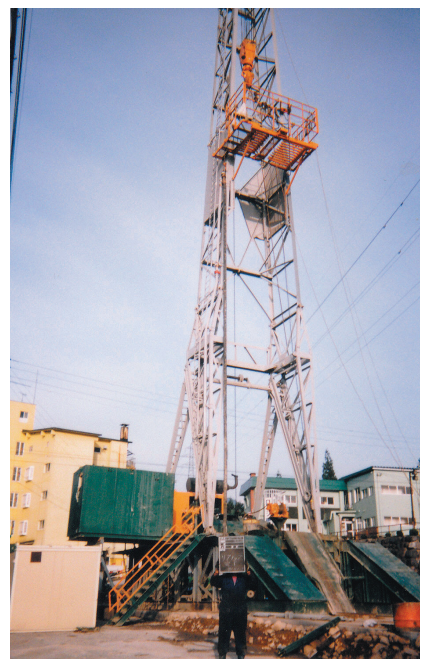
ボーリングのやぐら
