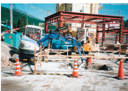
ポンプ室の掘削工事
