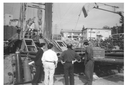
7号ケーシングパイプ・ストレーナー 立会
